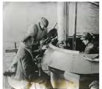
Arbeiten an der Brückenverkleidung
