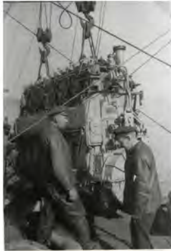
Der Dieselmotor wird eingebaut
