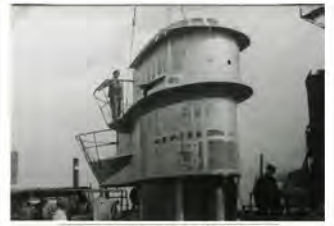
Die Turmverkleidung mit der Brücke und den beiden Flakplattformen (Wintergürteln) werden aufgesetzt
