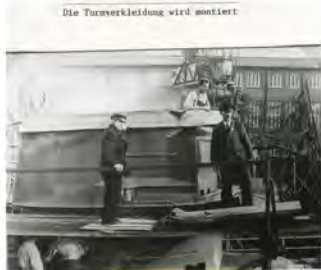
Die Turmverkleidung wird montiert
