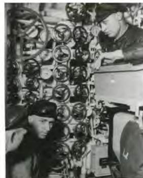
Auch im Inneren des Bootes wird montiert, hier der Druckluftverteiler
