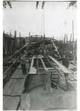
Das Oberdeck wird montiert
