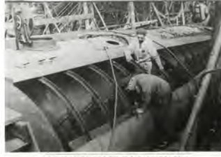
Die Satteltanks werden verkleidet
