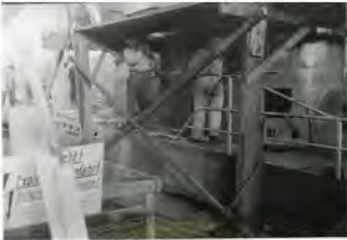
Die Turmverkleidung wird montiert
